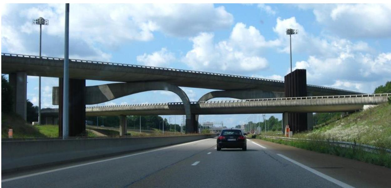
**Рисунок 8. Изыщное устройство промежуточной опоры путепровода**
