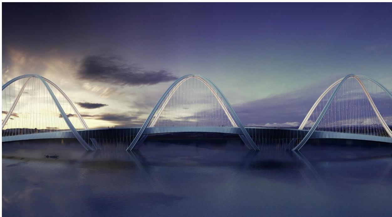
**Рисунок 2. Мост арочно-подвесной системы с фальш (декоративными) элементами**
