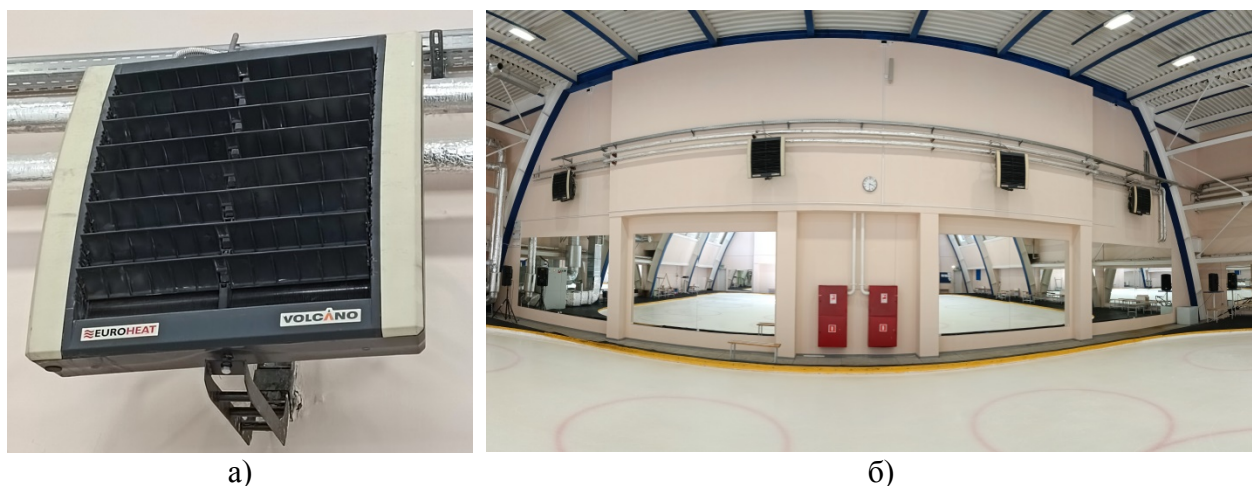
Рисунок 2.2 – Водяной тепловентилятор VOLCANO VR2 (а) и его размещение в помещении СПб ГБУ СШОР по фигурному катанию на коньках (б)
