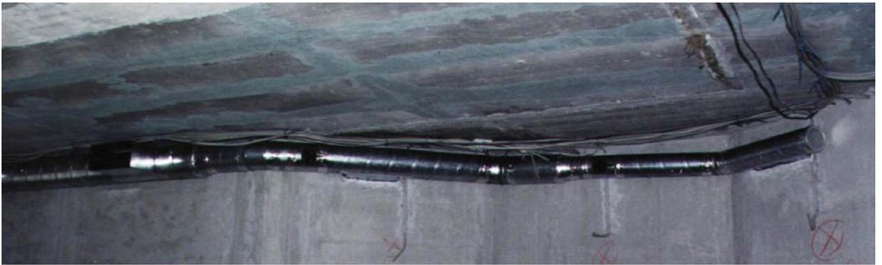
**Рисунок 3-4. Воздуховод с отводами и переходами с одного диаметра на другой**
