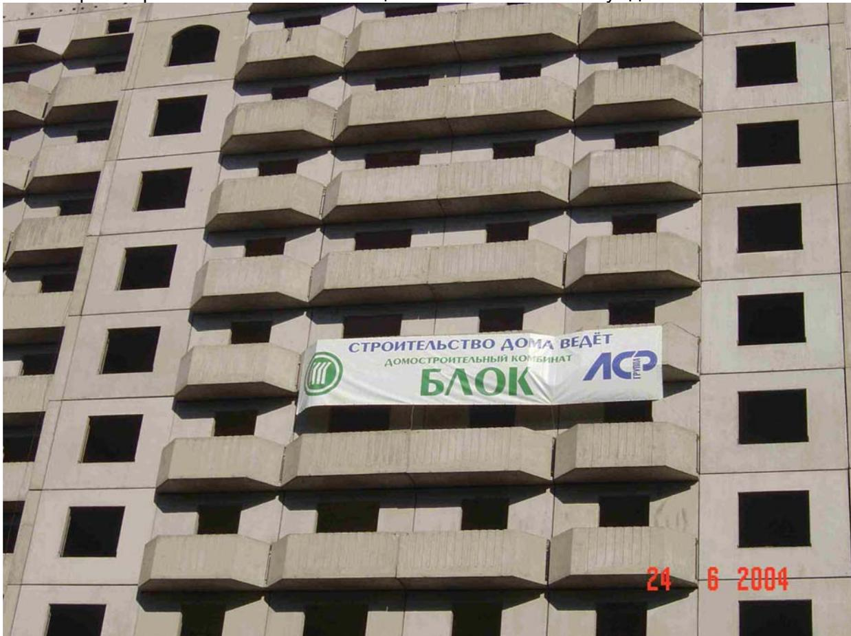
Рисунок 2-7. Дом из сборного железобетона, выпускаемый ОАО «ДСК БЛОК»
