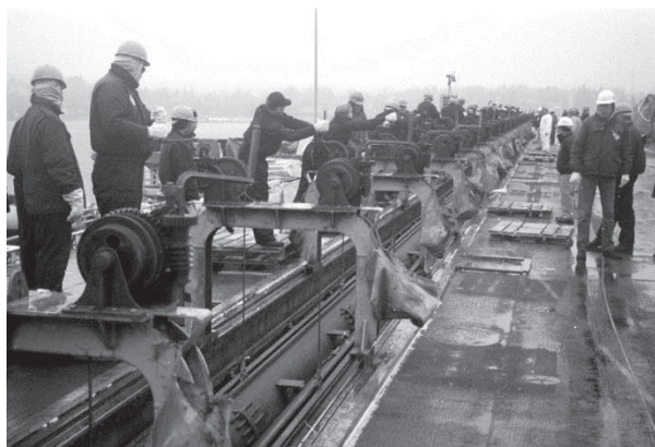
Рис. 4. Ремонт паровой катапульты на палубе американского авианосца
