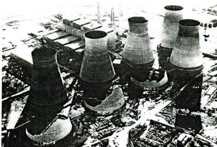
Рисунок 4. Обрушение градирен на ТЭС Феррибридж
