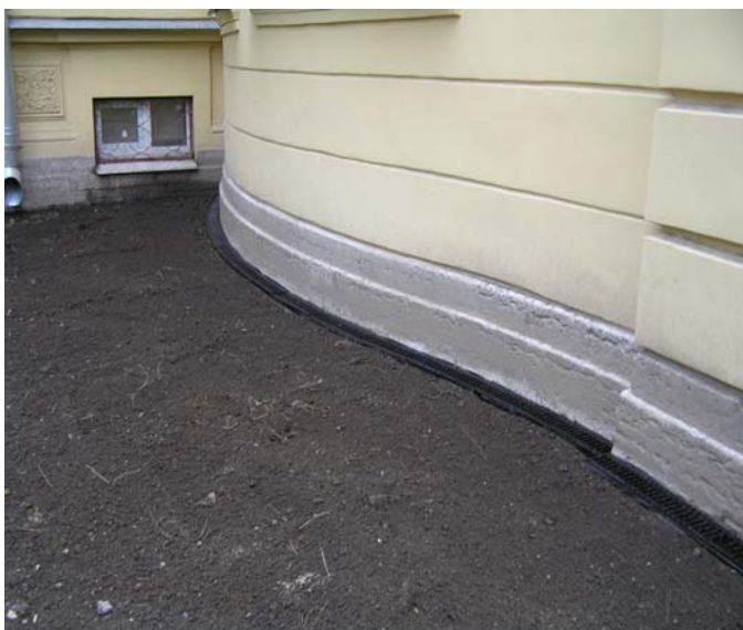
Рисунки 32-33. Обустройство пристенного лотка
