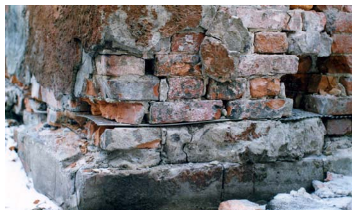
Рисунки 25-28. Противокапиллярная отсечка по технологии «System Baumann»
