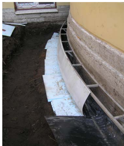
Рисунки 32-33. Обустройство пристенного лотка
