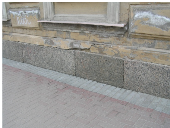
Рисунок 11. Караванная ул., д.1. Капиллярный подсос воды из сырого подполья
