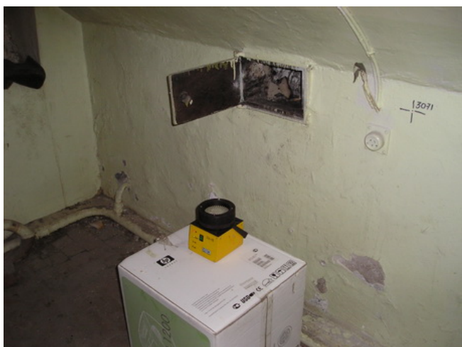
Рисунок 1. Вентканал в стене дома постройки XIX века
