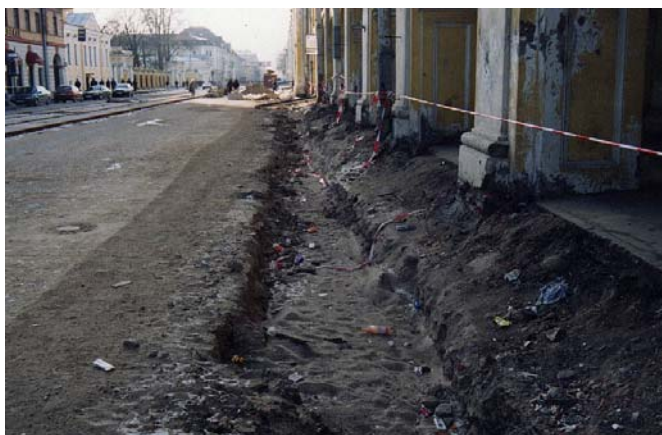
Рисунок 14. Обратная засыпка траншеи произведена песком
