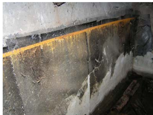
Рисунок 22. Гидроизоляция изнутри выполнена рулонным материалом без пригруза
