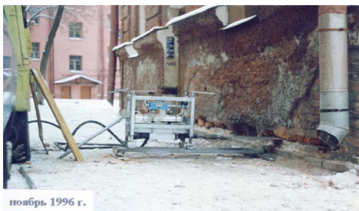
Рисунки 25-28. Противокапиллярная отсечка по технологии «System Baumann»
