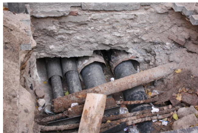
Рисунок 15. Пробивка фундамента при прокладке коммуникаций
