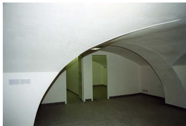
Рисунок 34. Стены подвала зашиты гипроком, но каждый лист имеет вентиляционную решётку
