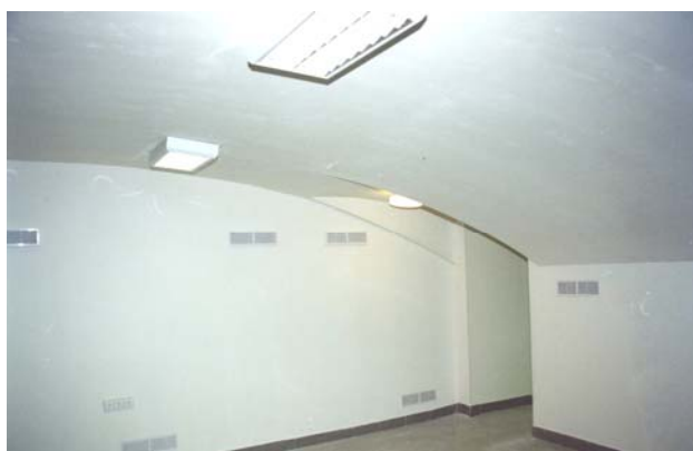
Рисунок 34. Стены подвала зашиты гипроком, но каждый лист имеет вентиляционную решётку
