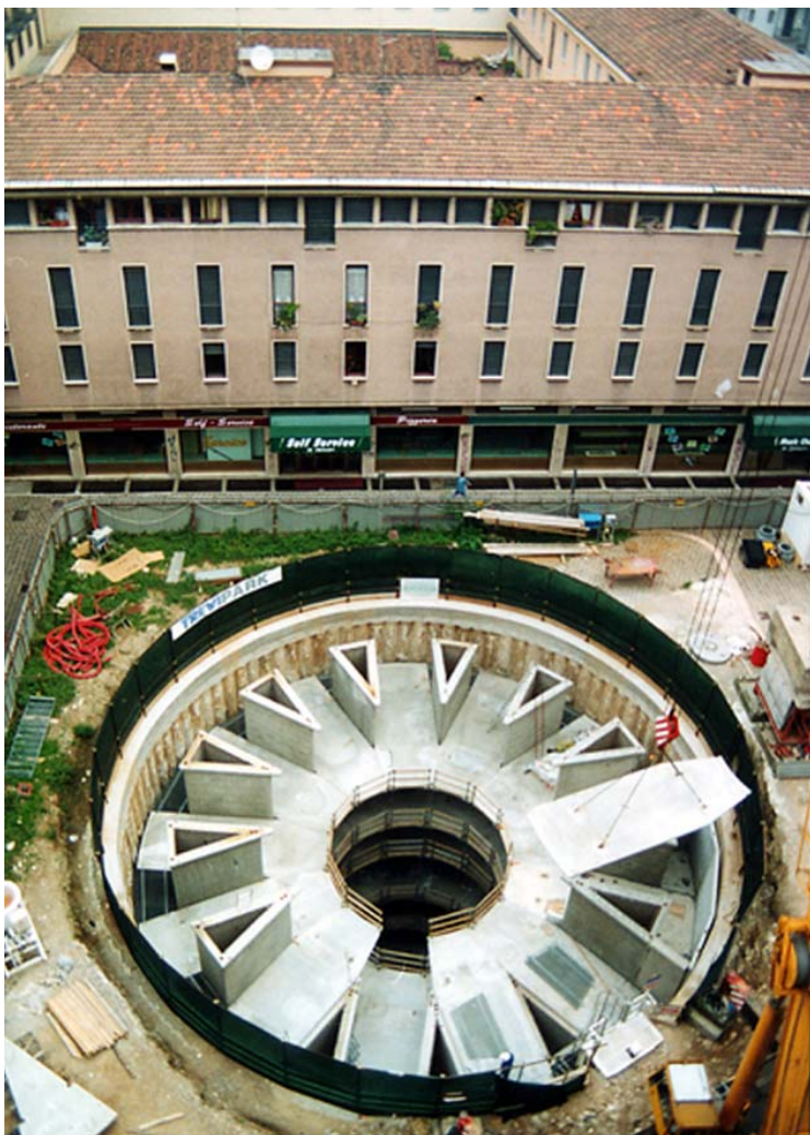
Рисунок 6. Монтаж внутренних конструкций паркинга
