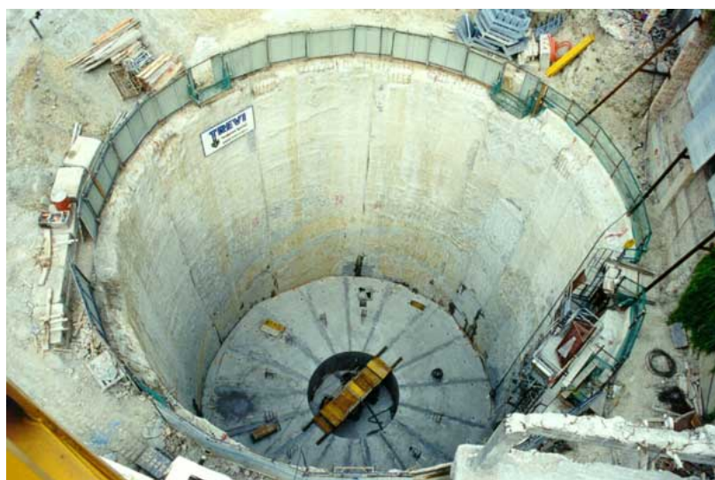
Рисунок 5. Сооружение шахты паркинга
